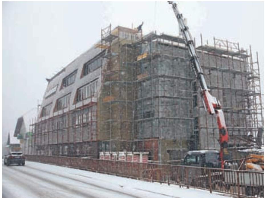
V prvi fazi bodo obnovili streho ter izdelali fasado, vhod v stavbo in jašek za dvigalo.
